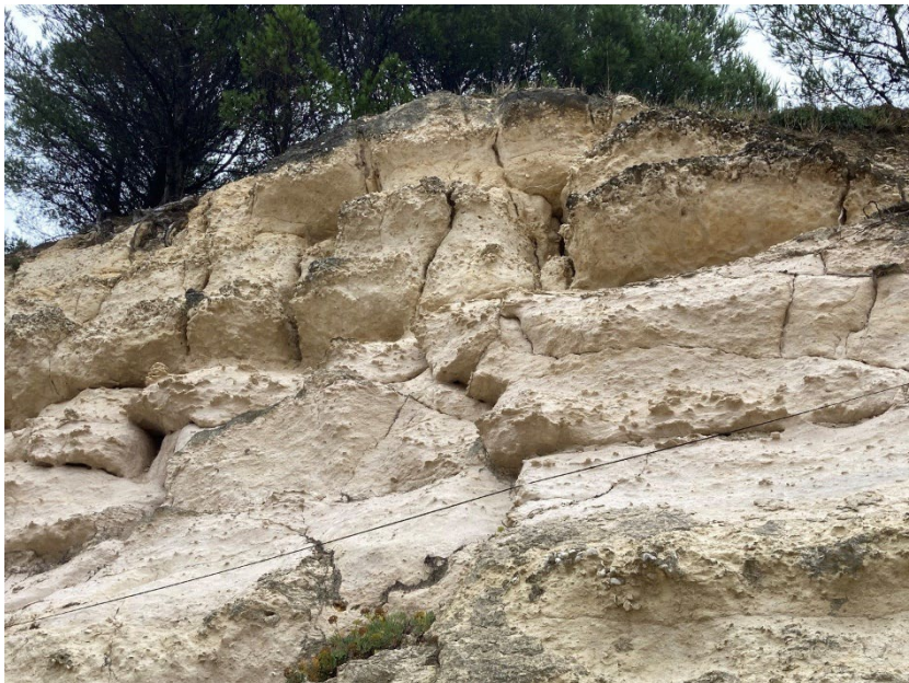
Illustration 12 - Banc de calcaires marneux fracturés et localement en surplomb, sujets à érosion superficielle (partie haute de paroi, aux abords de la zone d'expertise)
