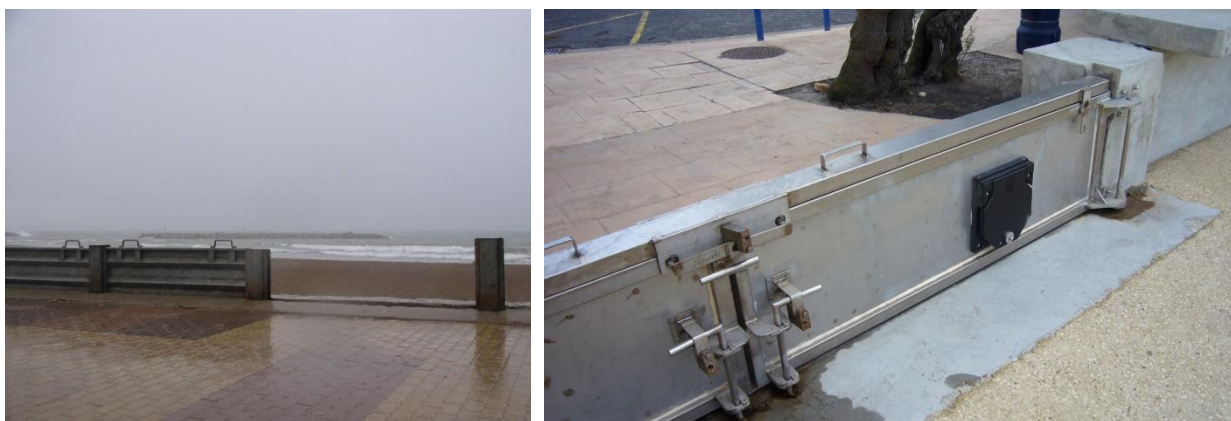
Figure 12 : Gauche : Batardeau en cours d'installation, Valras-Plage (2006). Photo Manuel Garcin. Droite : Fermeture d'une porte étanche à Andernos (2012). Photo Manuel Garcin.
