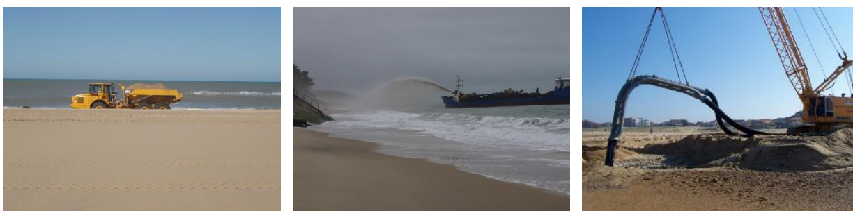
Figure 16 : Gauche : rechargement par camion à Montalivet (2014). ©Observatoire de la Côte Aquitaine. Milieu : rechargement par refoulement à Pyla-sur-Mer (2014). ©Observatoire de la Côte Aquitaine. Droite : Installation du système de by-pass hydraulique à Capbreton (2008).Crédit photo : mairie Capbreton.
