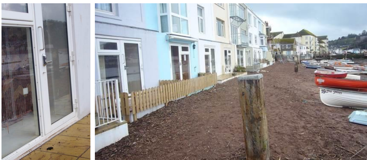
Figure 19 : Fenêtres étanches au rez-de-chaussée de maisons exposées à la submersion marine (zone urbaine en fond de baie à Teignmouth, Devonshire). Photo: Manuel Garcin
