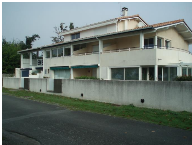
Figure 20 : Porte étanche, muret et clapets anti-retour facilitant l'évacuation de l'eau (Andernos, 33). Photo : Thomas Bulteau.
