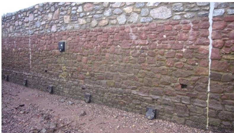
Figure 25 : Clapets anti-retour sur buse d'évacuation d'eau en cas de submersion à Shaldon (UK). Photo : Manuel Garcin.
