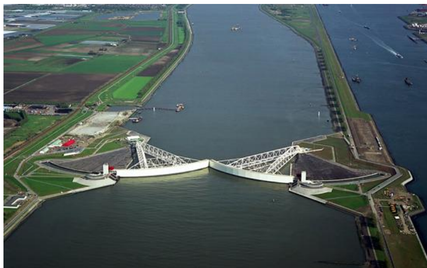
Figure 14 : Barrage « Maeslantkering » en position fermée en aval du port de Rotterdam (Pays Bas) (source Rijkswaterstaat)
