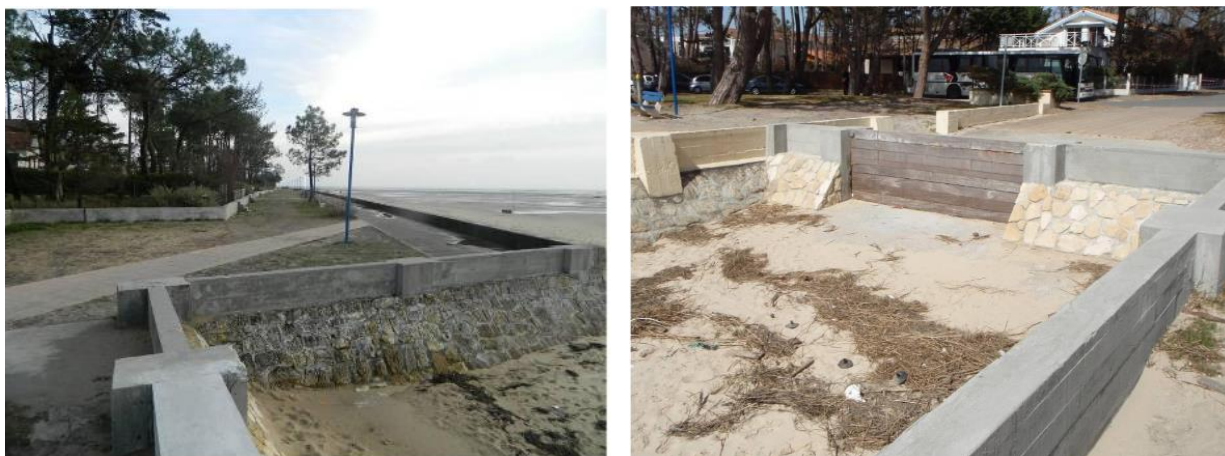
Figure 10 : Gauche : Rehaussement de muret et ajout d'une seconde ligne de murets en arrière suite à la tempête Xynthia (Andernos-les-Bains, Photo ©Observatoire de la Côte Aquitaine, Garcin, 2013). Droite : Rehaussement de muret et fermeture provisoire d'accès à la plage par batardeaux (Andernos les-Bains, Photo ©Observatoire de la Côte Aquitaine, Garcin, 2013).
