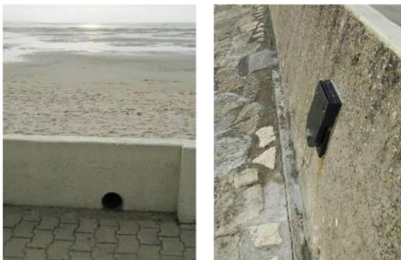
Figure 24 : Buse d'évacuation équipée d'un clapet anti-retour coté océan à Andernos-les-Bains (Photo Observatoire de la Côte Aquitaine, 2013).
