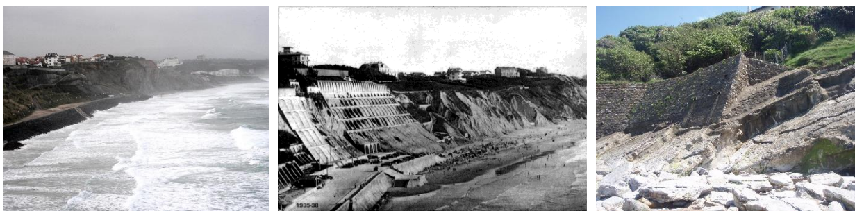
Figure 18 : Gauche : Perrés en haut de plage. Côte des Basques, 2006. Photo: Manuel Garcin. Milieu : La côte des Basques à Biarritz (entre 1935 et 1938). À noter le début des travaux de confortement (à gauche) et le caractère très instable de la falaise en arrière-plan. Droite : Mur de soutènement, Guéthary, 2015. ©Observatoire de la Côte Aquitaine.
