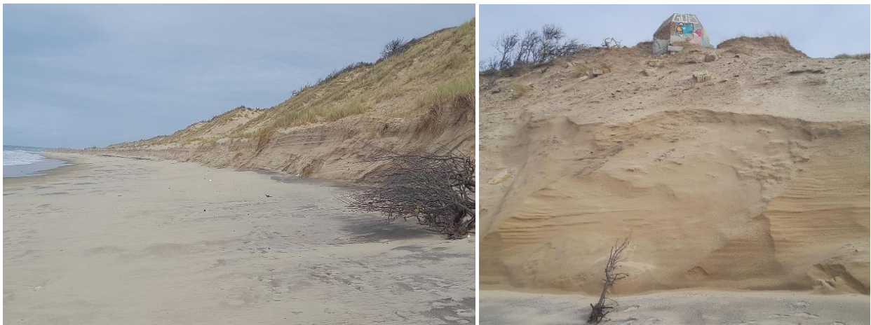
Figure 11 - Plage située entre le sud du rocher Saint-Nicolas et le nord des digues d'Arros, vues vers le nord (à gauche) et l'est (à droite) le 08/11/2023 © Observatoire de la côte de Nouvelle-Aquitaine
