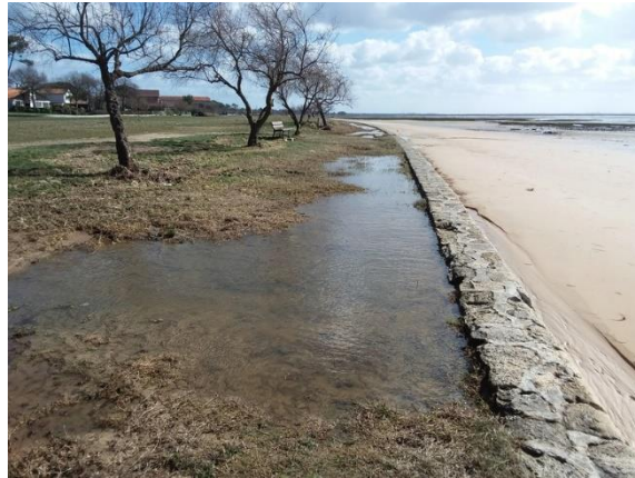
Figure 13 : Taussat. Trace de submersion par franchissement de paquets de mer
