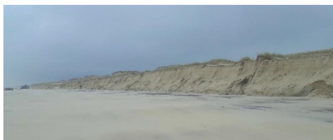
Figure 38 - Plage au sud des blockhaus du Lion le 12/02/2024, vue nord-est. © Observatoire de la côte de Nouvelle-Aquitaine
