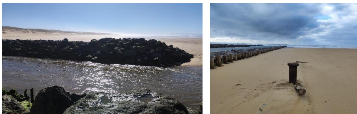
Figure 65 - Digue du courant de Soustons le 13/02/2024, vue sud (à gauche) et ouest (à droite). © Mairie de Vieux-Boucau-les-Bains
