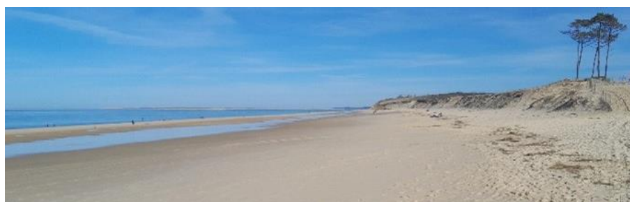
Figure 47 - Plage de la Lagune le 14/02/2024, vue nord. © Observatoire de la côte de Nouvelle-Aquitaine
