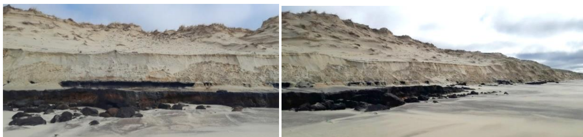
Figure 32 – Secteur au nord de Lacanau-Océan le 12/02/2024, vue est (à gauche) et sud (à droite). © Observatoire de la côte de Nouvelle-Aquitaine
