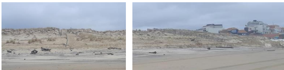
Figure 34 - Plage Nord le 12/02/2024, vue est (à gauche) et sud-est (à droite). © Observatoire de la côte de Nouvelle-Aquitaine
