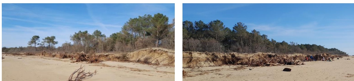
Figure 25 - Plage de la Lède le 12/02/2024, vue nord-ouest (à gauche) et sud-est (à droite). © Observatoire de la côte de Nouvelle-Aquitaine
