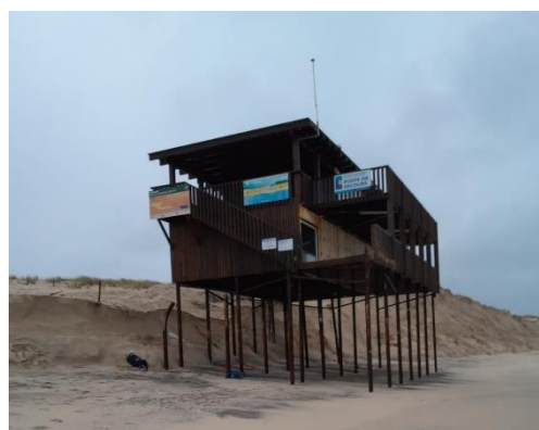
Figure 27 - Poste MNS de la Salie Nord avant son démontage (source ONF)
