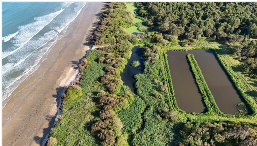
Figure 25 - Prise de vue aérienne du lagunage de la station d'épuration de Saint-Trojan-les-Bains
