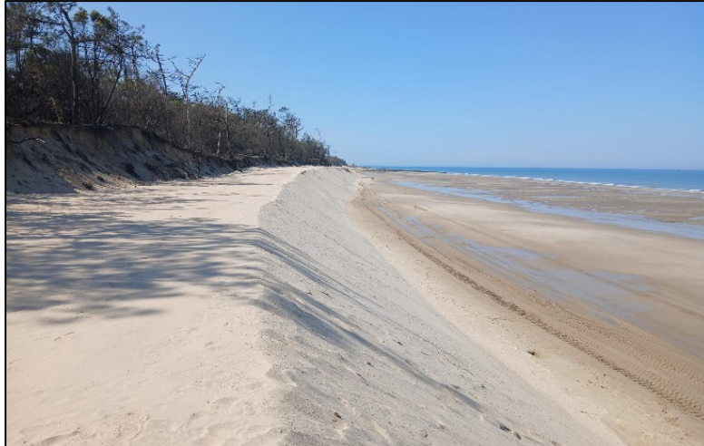
Figure 25 : Après les érosions marines, travaux de réensablement au sud de Soulac (Source ONF)
