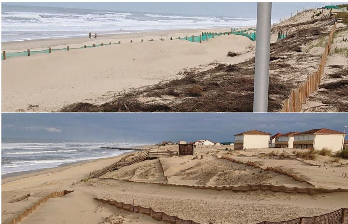
Figure 14 – Ensablement des filets coco disposés au nord du courant de Mimizan (en haut) et plage sud de Mimizan (en bas) le 11/12/2024. © B. Duport.
