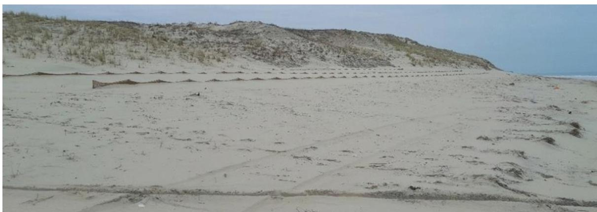
Figure 12 – Secteur dit de l’Observatoire où les filets coco ont été quasiment recouverts, le 11/12/2024. © Observatoire de la côte de Nouvelle-Aquitaine.
