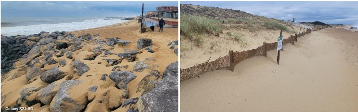
Figure 16 – Enrochement du Santocha au sud de la plage du Prévent (à gauche) et pied de dune dans la zone centrale de la plage du Santocha (à droite) le 09/12/2024. © Mairie de Capbreton.
